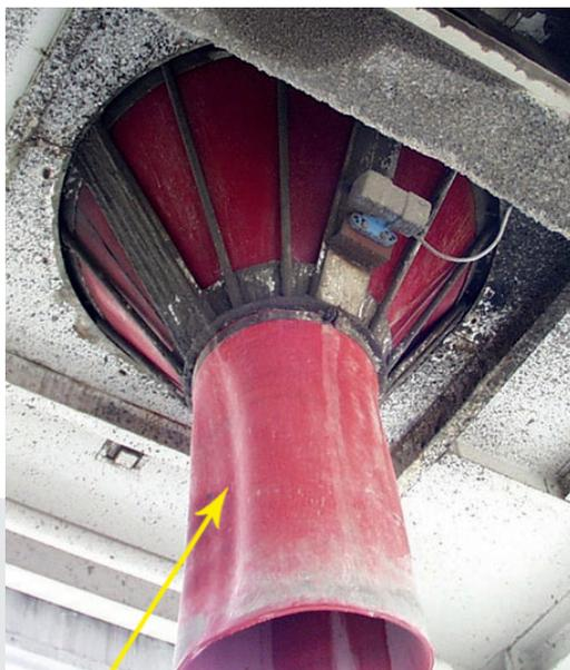
▲ Ein PUCESST Auslaufschlauch an einem PUCESST Auslauftrichter
