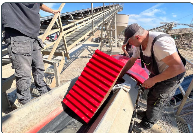
SZ-Platten halb hängend, einfacher Zuschnitt und Montage durch unser Team
